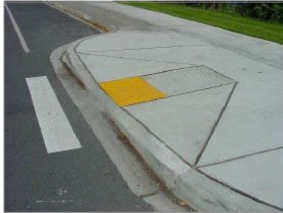
Σχήμα 10.4. Διαμόρφωση ράμπας για πλάτος πεζοδρομίου μεγαλύτερο από 3,90μ.
