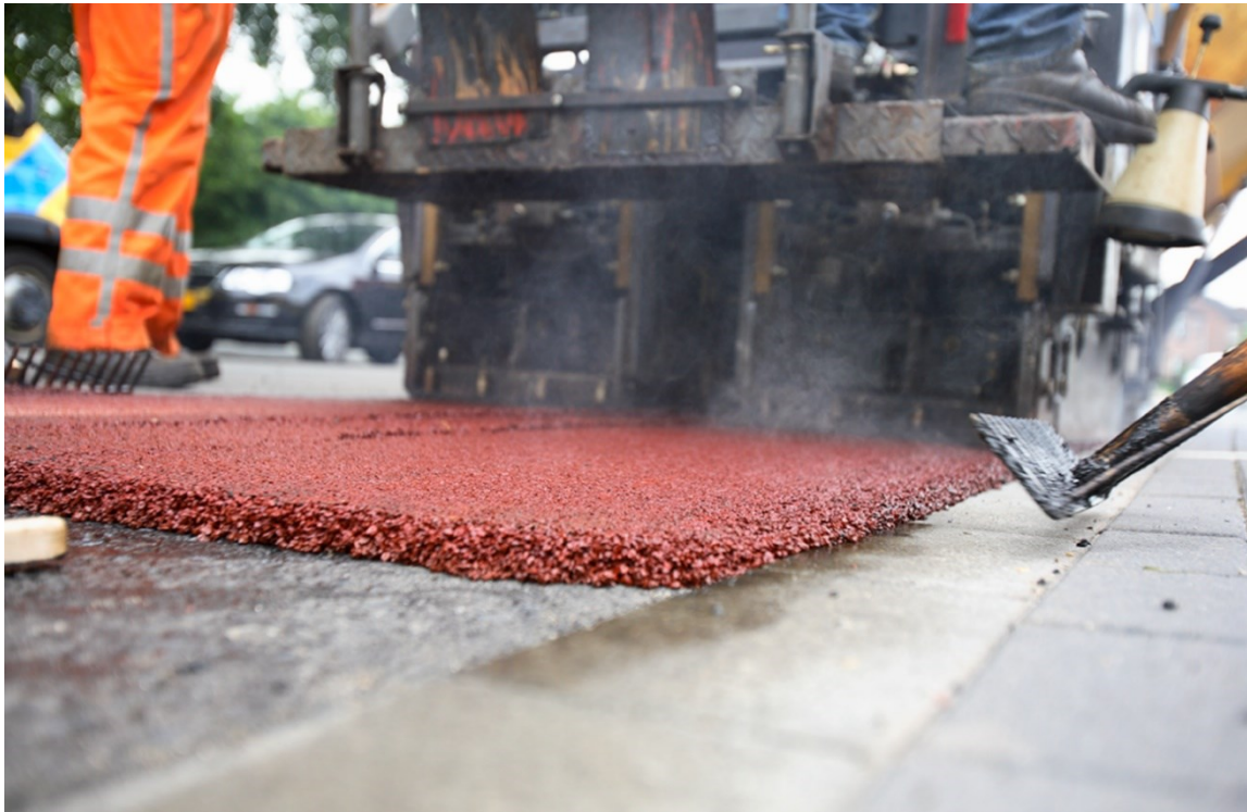
Εικόνα 10.2. Εφαρμογή έγχρωμης ασφάλτου (2/3).
