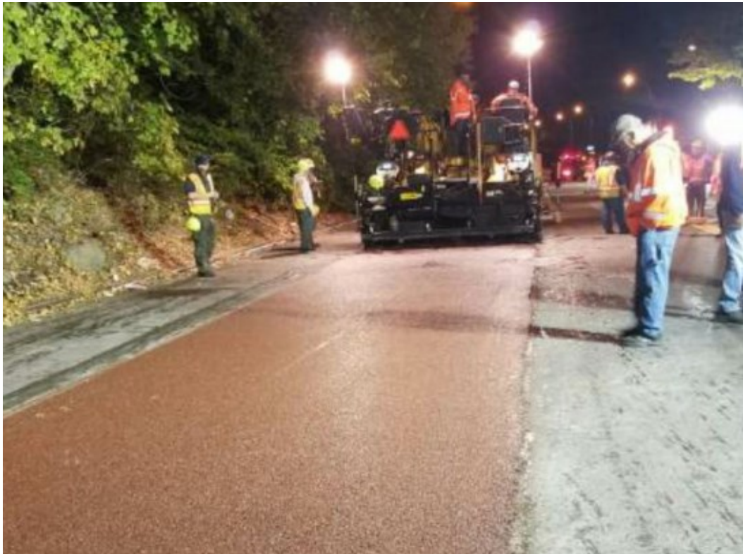
Εικόνα 10.2. Εφαρμογή έγχρωμης ασφάλτου (2/3).
