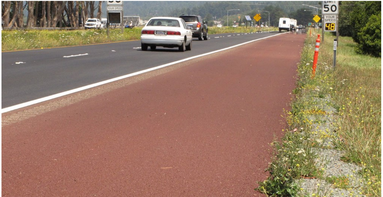
Εικόνα 10.3. Εφαρμογή έγχρωμης ασφάλτου (3/3).
