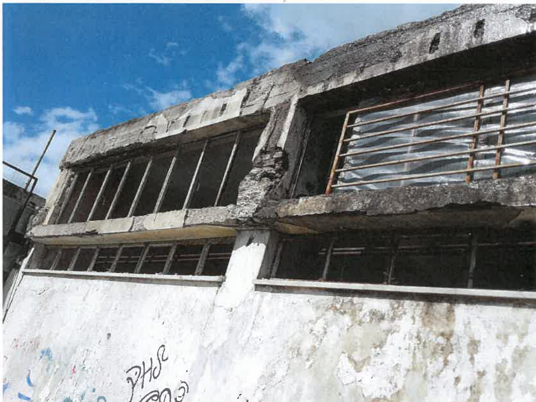
ΕΝΤΟΝΕΣ ΔΙΑΒΡΩΣΕΙΣ ΟΠΛΙΣΜΟΥ, ΕΝΑΝΘΡΑΚΩΣΗ ΣΚΥΡΟΔΕΜΑΤΟΣ ΚΑΙ ΔΙΑΡΡΗΞΗ ΕΠΙΚΑΛΥΨΗΣ , ΠΑΡΑΜΕΝΟΥΣΑ ΥΓΡΑΣΙΑ
