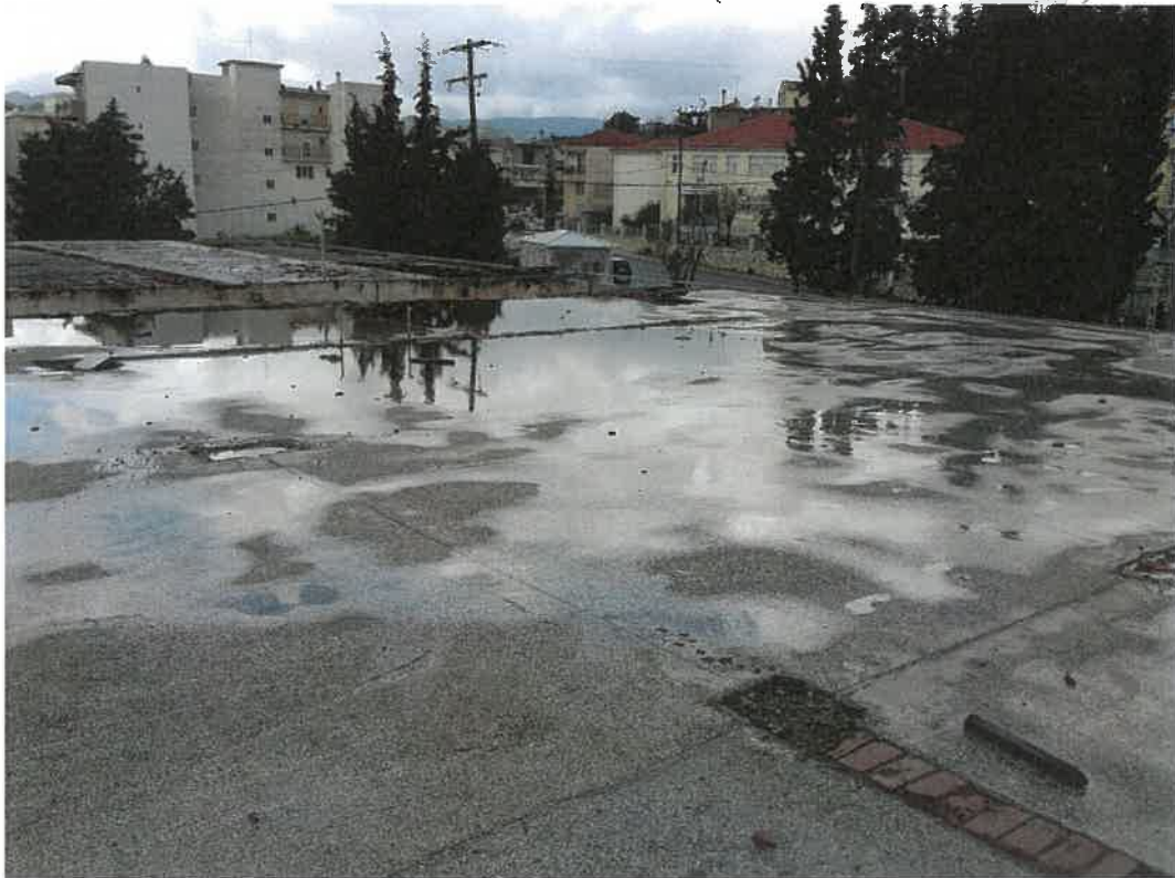
ΑΠΟΨΗ ΟΡΟΦΗΣ ΠΛΑΚΑΣ ΙΣΟΓΕΙΟΥ (ΠΑΡΑΜΟΝΗ ΥΔΑΤΩΝ)
